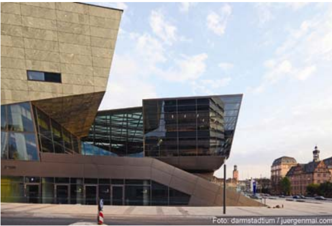
Foto: darmstadtium / juergenmai.com Das Tagungsgebäude in Darmstadt
